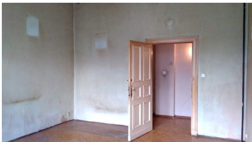
„Mieszkanie do remontu”, fot. ZKZL.
